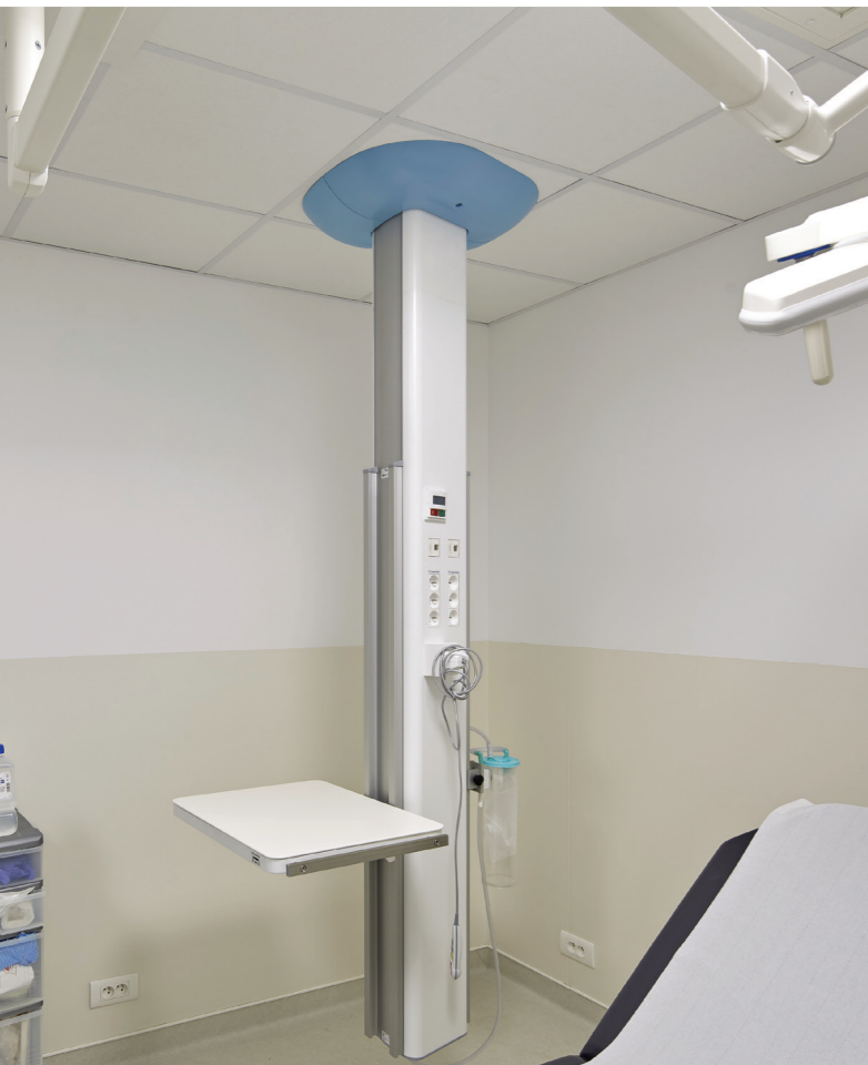
Hôpital Privé des Côtes d'Armor, Plérin Côtes d'Armor Private Hospital, Plérin, France
