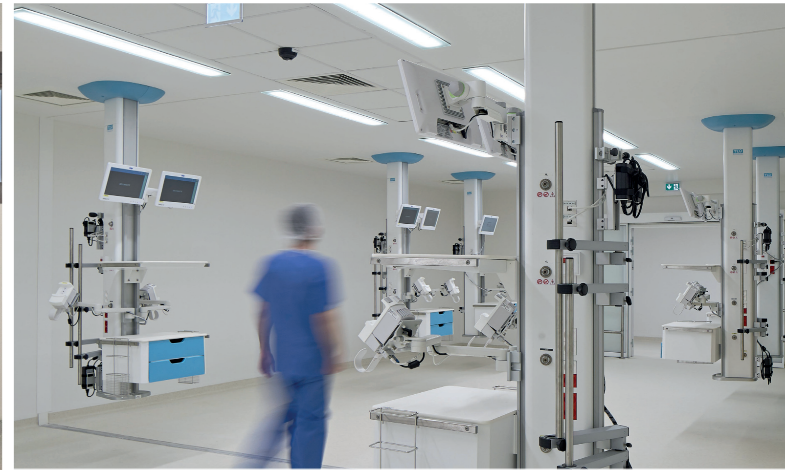
Hôpital Privé de Provence, Aix-en-Provence Provence Private Hospital, Aix-en-Provence, France
