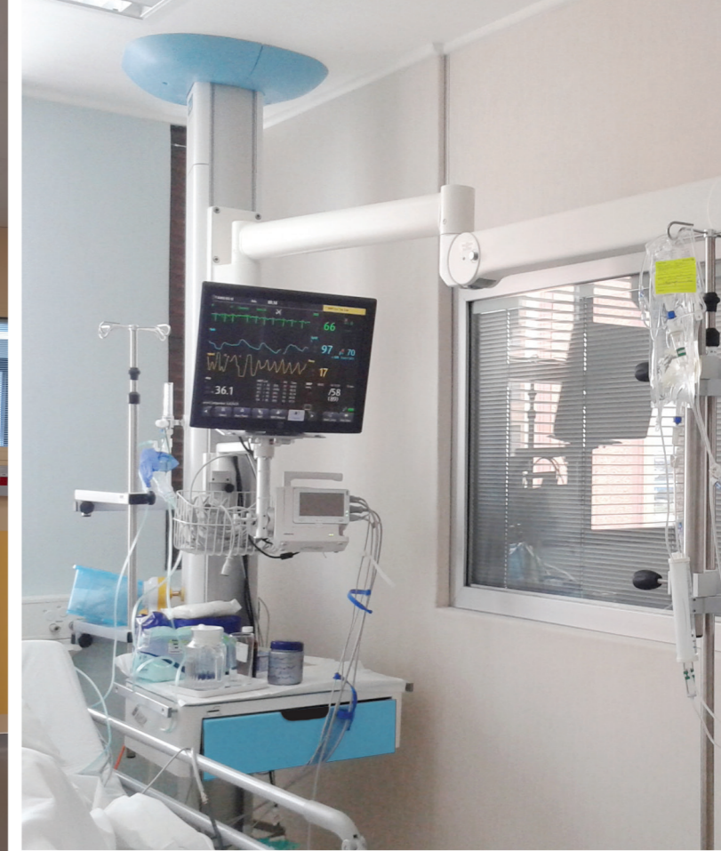
Hôpital Arwyp, Kempton Park (Johannesburg), Afrique du Sud Arwyp Medical Center, Kempton Park (Johannesburg), South Africa
