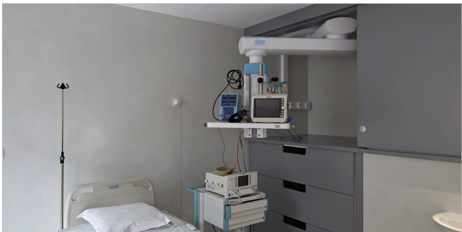
■ BRAS PLAFONNIER TECH-CARE ERGOFIX INTÉGRÉ DANS UN PLACARD, SALLE D'ACCOUCHEMENT
